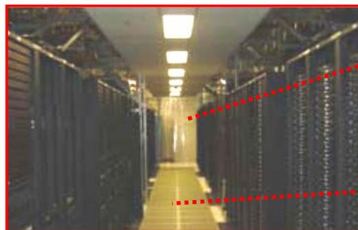
コールドアイルの両端の天井から、プラスチック製のカーテンが吊り下げられている
