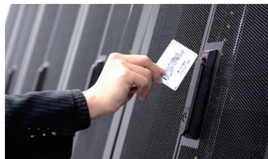
NetBotz Rack Access PX-HID : 電子錠
