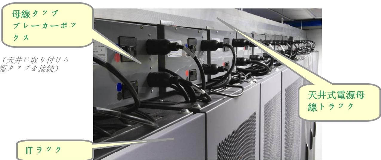
すべてのIT機器列に母線路を事前に設置することにより、従来の配電方式の問題が解消され、変更が容易になり、床下配線も不要になります。従来の配電方式に代わる最初的方式として登場した天井式ラック配電によって、柔軟で再構成可能な配電システムが実現しました。天井式ラック配電は代替方式として今も有効ですが、実用面のデメリットがいくつかあります。このホワイトペーパーで紹介した新しいモジュール式PDU構造は、これらの短所を克服する方式です。表 2 は天井式ラック配電とモジュール式配電方式の比較です。
