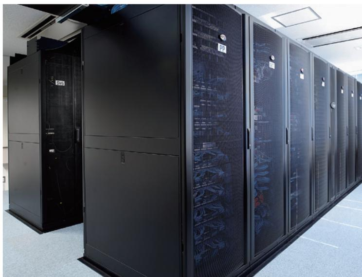
大学院として先端的な教育・研究を行なう総合研究大学院大学では、教育・研究や大学運営を支えるインフラの運用においても先端的な取り組みを積極的に続けている。2012年には、運用状況の可視化と効率的な運用を目指した新しいサーバールームをラックシステムとして構築。効率の良い水冷式冷却システムであるInRow RCを始め、モジュール型UPSであるSymmetra PXや統合監視・管理ソフトウェアStruxureWare Data Center Expertなど、シュナイダーエレクトリックの製品が多数採用されている。
