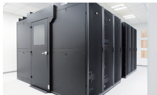
NECネットエスアイのサーバーールームに設置されたHACS
